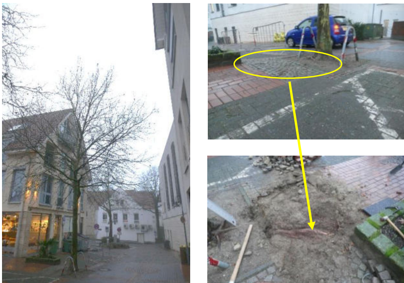
Abb. 5 – 7. Platane im Stadtgebiet von Ibbenbüren. Wurzeln sind aus der kleinen Baumscheibe in die Wegetragschichten eingewurzelt. Infolge des sekundären Dickenwachstums ist es innerhalb weniger Jahre zu deutlichen Belagsanhebungen gekommen.
