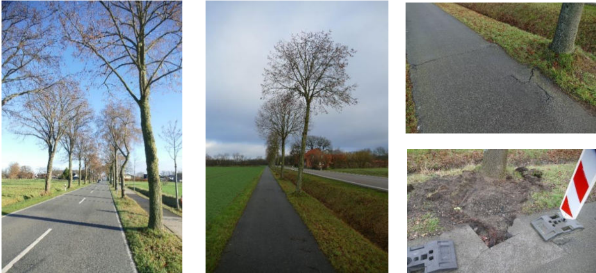
Abb. 1 – 4. Radwege entlang von Kreisstraßen im Münsterland und Osnabrücker Land als Beispiel für die vielfältige Funktionserfüllung straßenbegleitender Alleen und Baumreihen. Gleichzeitig zeigt sich an den Belagsausbesserungen, -verwerfungen und einwachsenden Wurzeln das Konfliktpotential, welches sich aus den geringen Abständen der Bäume zu den jeweiligen Verkehrswegen ergibt.
