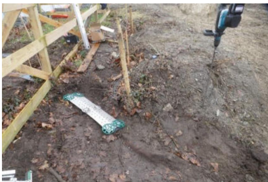
Abb. 33 – 34. Beispiele für anpressende Wurzelschutzbleche, die für einen begrenzten Zeitraum die Standsicherheit eines Baumes erhöhen können, indem sie Teilfunktionen beschädigter und/oder entnommener Einzelwurzeln übernehmen. Die bis in 1,50 m Tiefe eingetriebenen Erdanker übernehmen hierbei u.a. Funktionen von Senkerwurzeln und erhöhen so die Scherfestigkeiten der einzelnen Wurzelteile im Boden.
