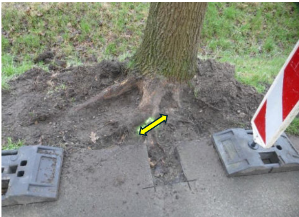
Abb. 16. Schadauslösend ist eine untergeordnete Starkwurzel, die sich Richtung Wegetragschicht entwickelt hat. Durch die Entnahme dieser Wurzel am Gabelungspunkt zur unmittelbaren Nachbarwurzel sowie einem glatten Schnitt entlang der Saftstromebene lässt sich die schadauslösende Wurzel ohne größere Folgeschäden entnehmen. Voraussetzung ist der Erhalt der parallel des Weges verlaufenden, saftstromführenden, dominanten Starkwurzel als Kompensationswurzel.
