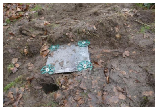
Abb. 33 – 34. Beispiele für anpressende Wurzelschutzbleche, die für einen begrenzten Zeitraum die Standsicherheit eines Baumes erhöhen können, indem sie Teilfunktionen beschädigter und/oder entnommener Einzelwurzeln übernehmen. Die bis in 1,50 m Tiefe eingetriebenen Erdanker übernehmen hierbei u.a. Funktionen von Senkerwurzeln und erhöhen so die Scherfestigkeiten der einzelnen Wurzelteile im Boden.
