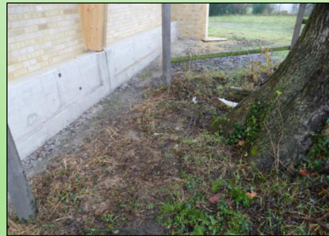
Stahlbetonwechselbalken zum wurzelschonenden Überbauen des Wurzelkörpers nach Wurzelsondierung.
