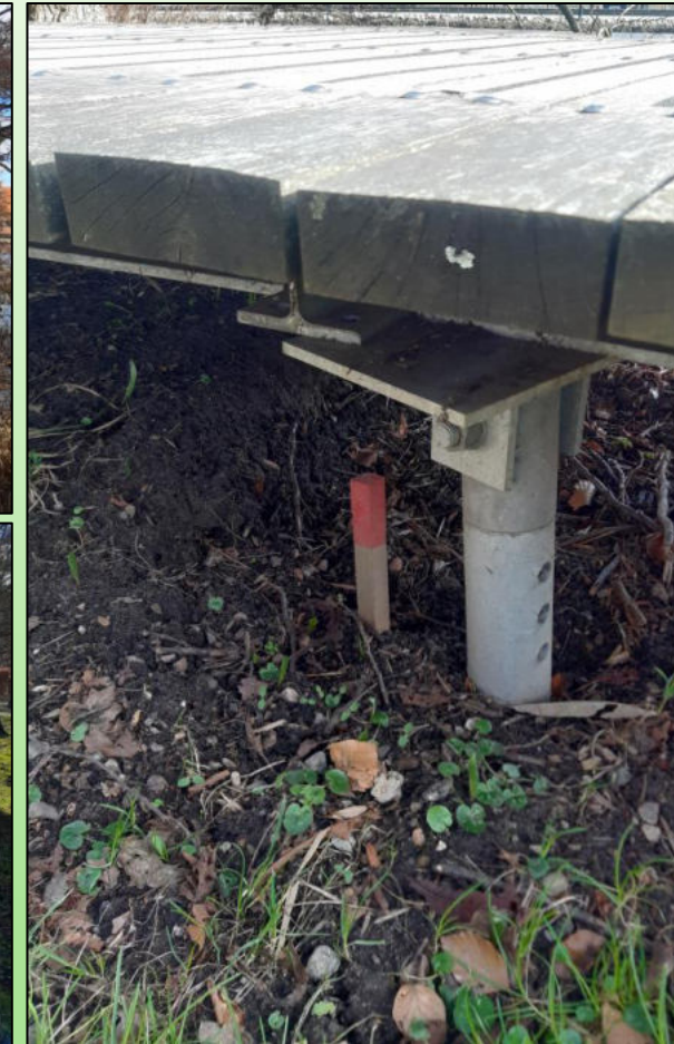
Breiter Holzsteg als bandförmige Wurzelbrücke, auf Schraubfundamenten aufliegend.
