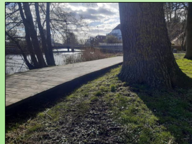
Breiter Holzsteg als bandförmige Wurzelbrücke, auf Schraubfundamenten aufliegend.
