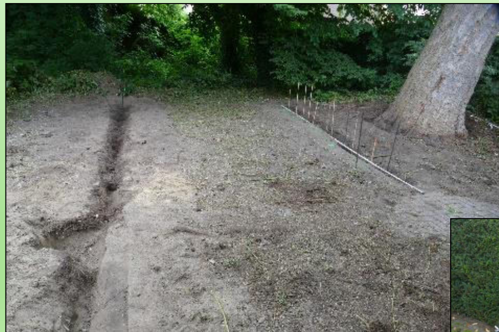
Suchgräben in Kombination mit Wurzelsondierung.
