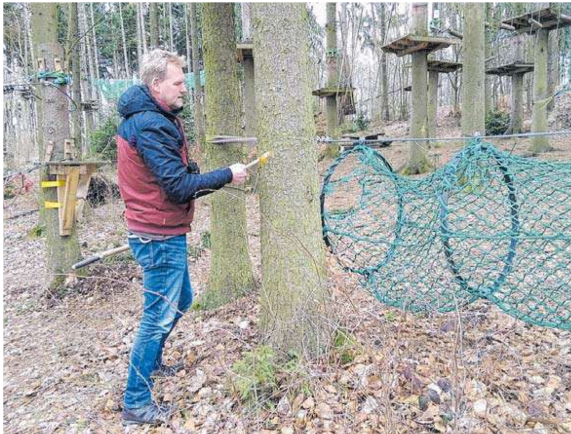
Baumgutachter Marc Wilde untersucht den Kletterwald an der Talsperre Pöhl ganz genau. Ob Fäulnis, Pilzbefall, Überlastung oder eingnisteter Borkenkäfer: Auge und Ohren des Profis entgeht nichts.
